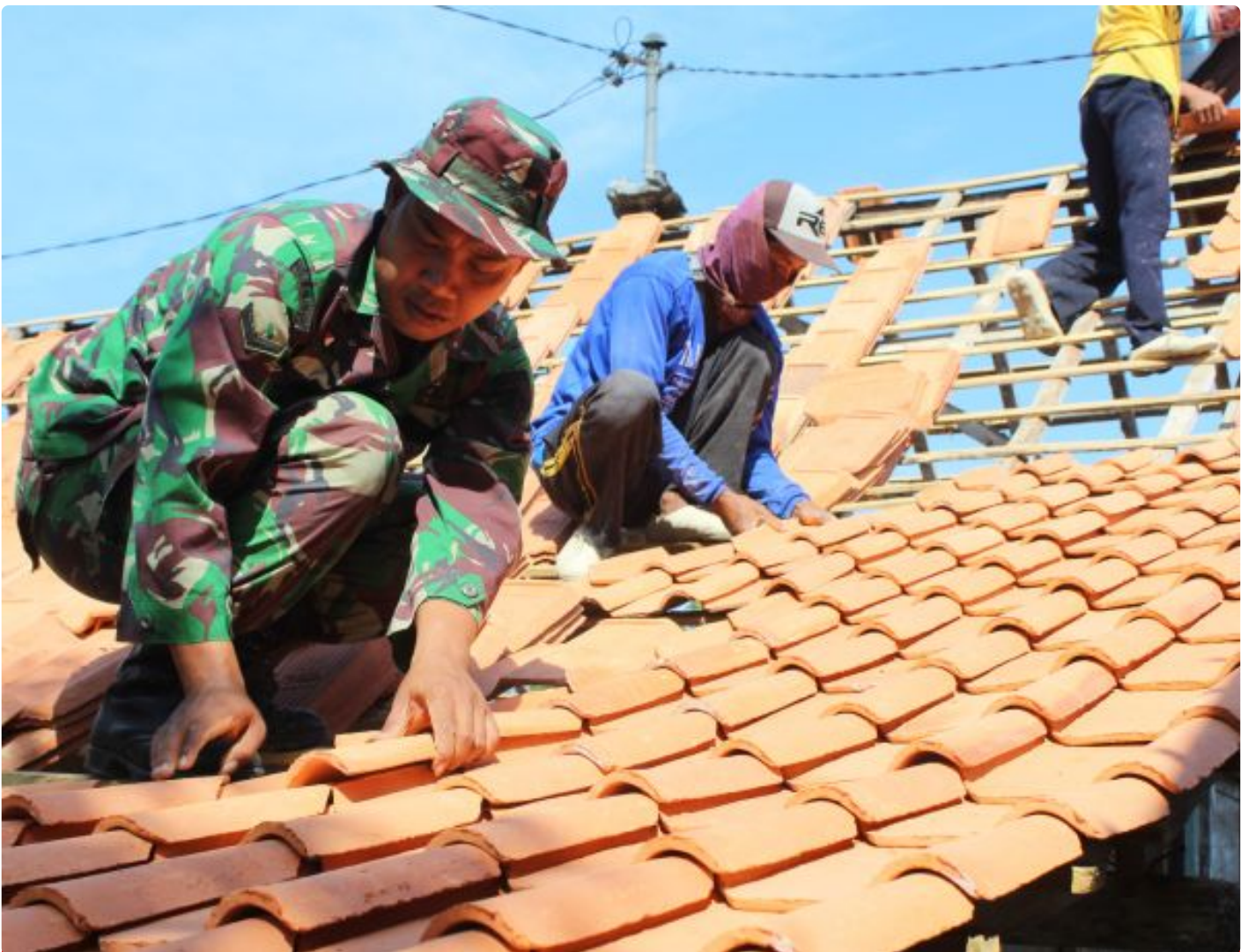
Foto : Satgas TMMMD Reg 122 Kodim 0721/Blora Pengerjaan Rumah Tidak Layah Huni.
